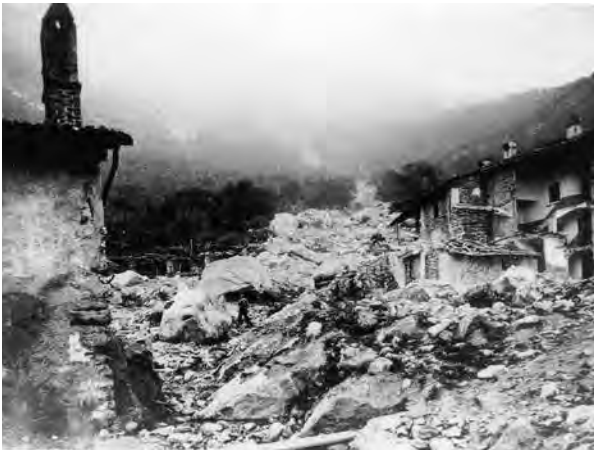
Quassolo (Torino). Settore apicale del rio Pisone (2,95 km 2 ) dopo l'alluvione del 12 giugno 1942. L'immagine mostra la capacità di trasporto solido di questo rio (20-30.000 m 3 ) e la violenza con la quale furono colpite alcune abitazioni del piccolo abitato.
